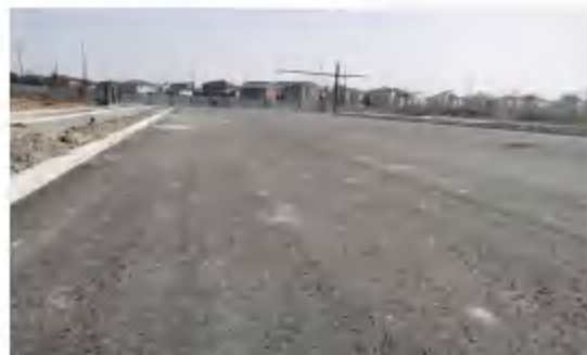
北側——在建道路
